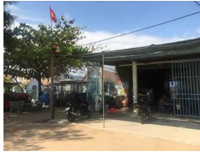
Hình: Các công trình tạm, nhà cấp 4 chất lượng không đảm bảo an toàn
